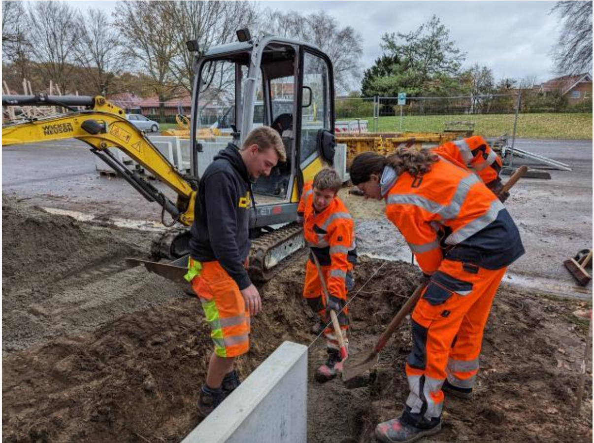
Beim Setzen der Kantensteine war Präzision gefragt. FOTO: URSACHENSTIFTUNG OSNABRÜCK
